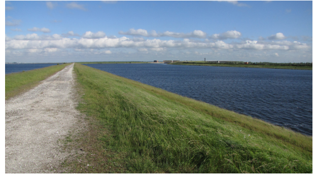
Figuur 3.4. N57 over de Philipsdam met sluizencomplex en Laagbekken, 16 juni 2010 (jwv).
