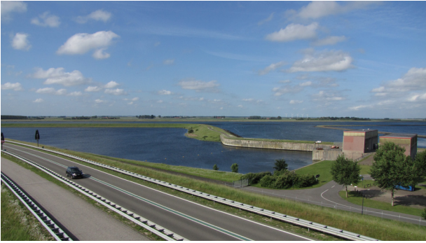
Figuur 3.3. Westelijke dijk Laagbekken Krammersluizen, 16 juni 2010 (jwv).
